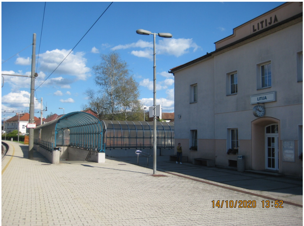
Slika 2: Pogled na obstoječi vhod v podhod, z zahodne strani.
