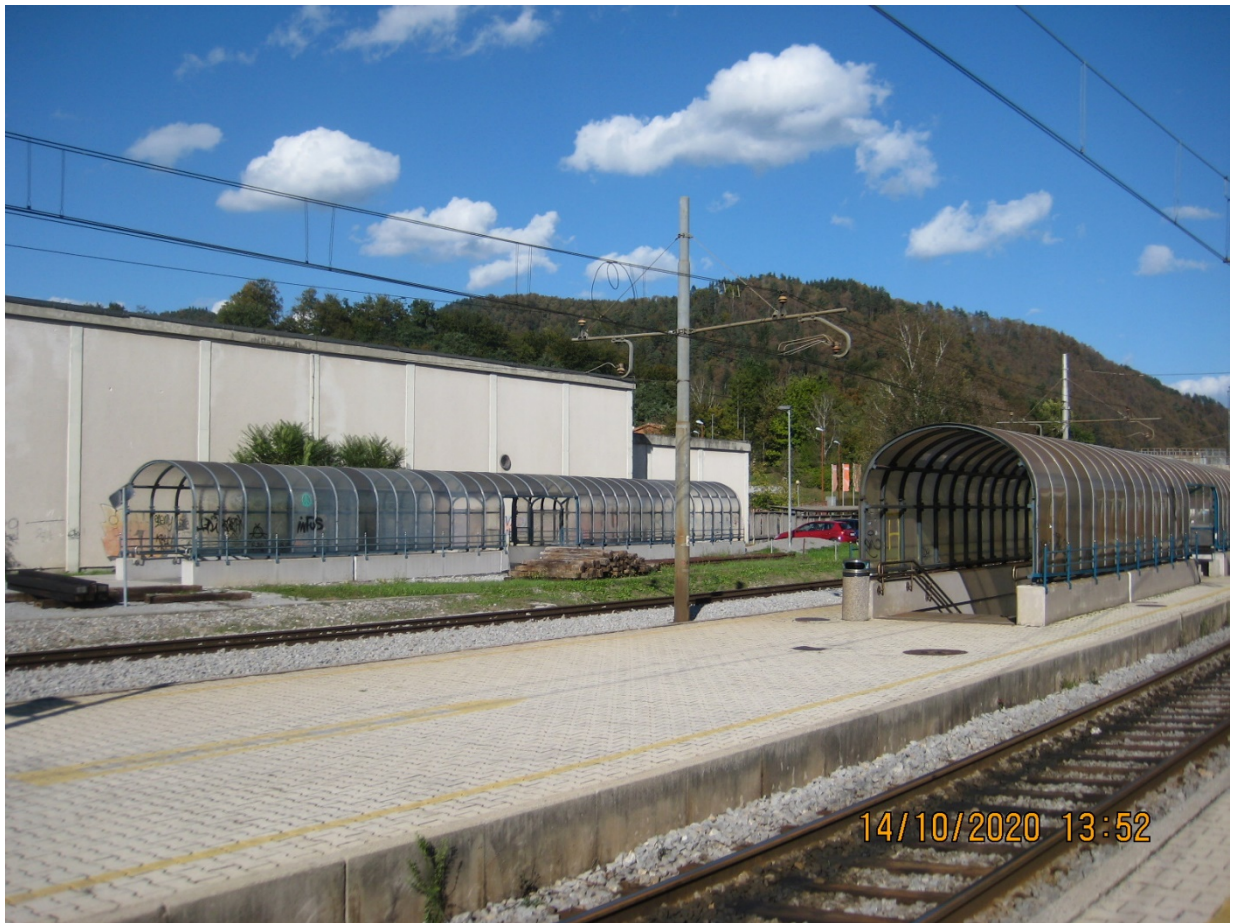
Slika 3: Pogled z zahodne strani na izhoda iz obstoječega podhoda.
